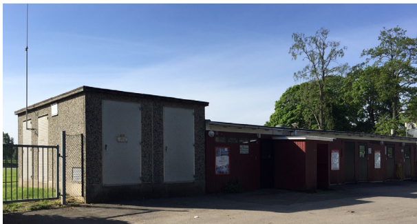
Nätstation vid entrén till Skara Arena
