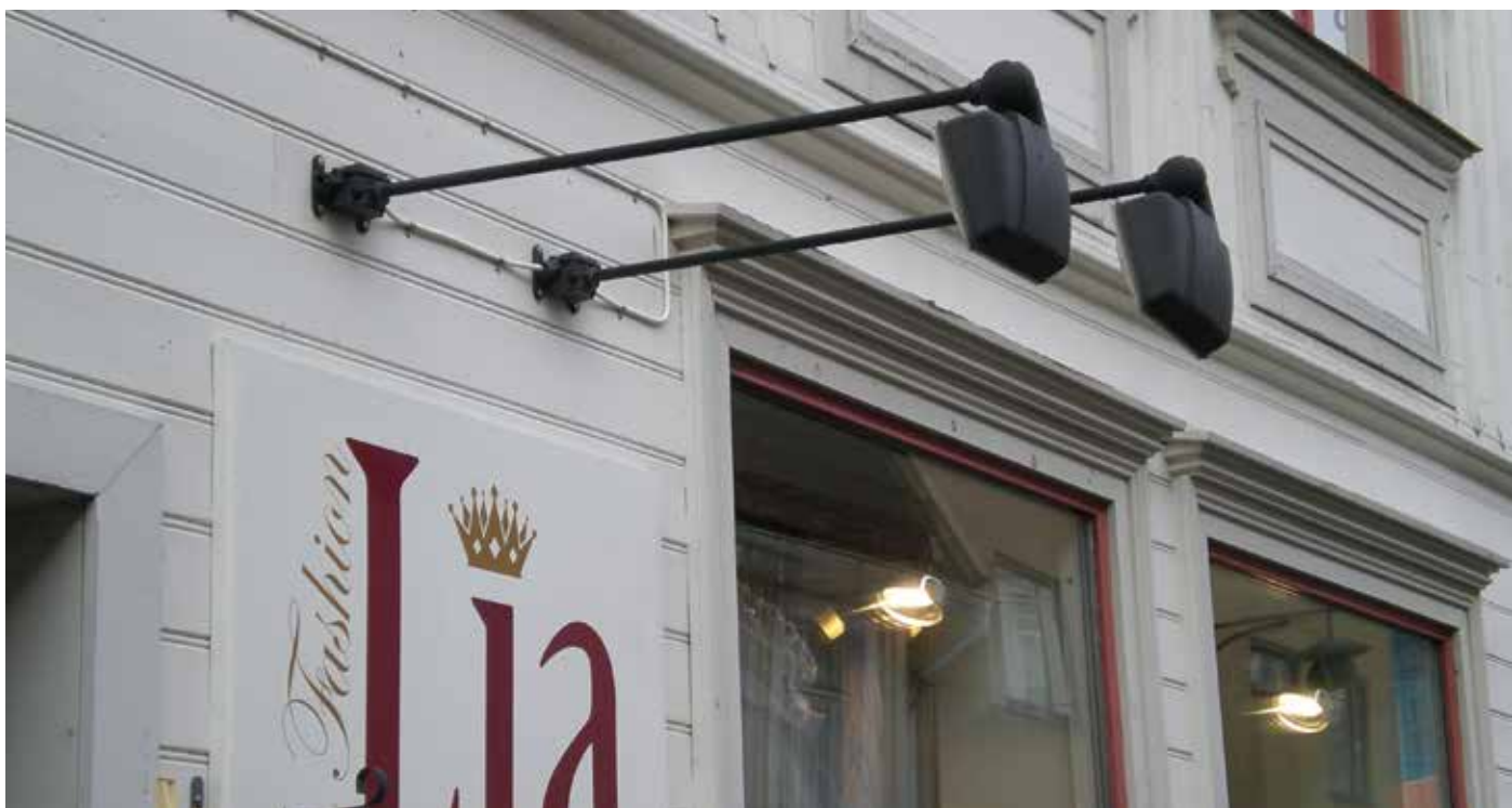
Belysningsarmaturer ljussätter skyltar från sidan eller framifrån. Belysningsarmaturer ska göras så diskreta som möjligt och inte ta uppmärksamhet från skylten eller upplevas som dominerande i gaturummet.
