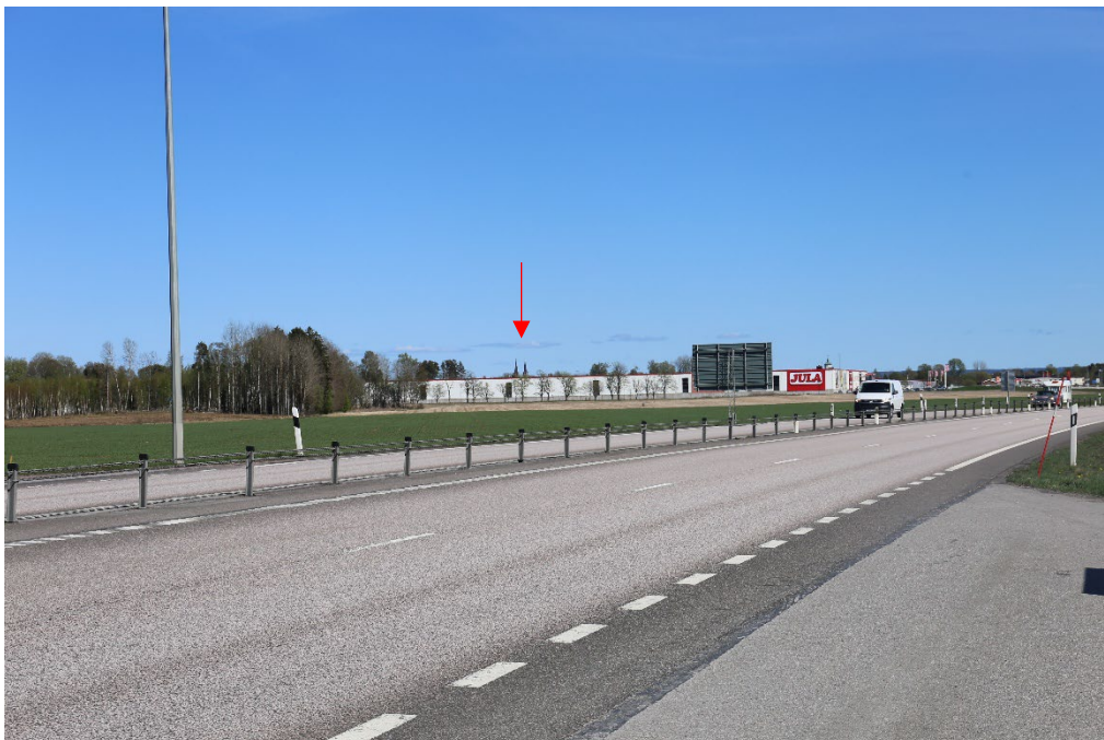
Vy från busshållplatsen Simmatorp längs E20. Röd pil pekar på domkyrkotornen. Vit byggnad är Julia centrallager.
