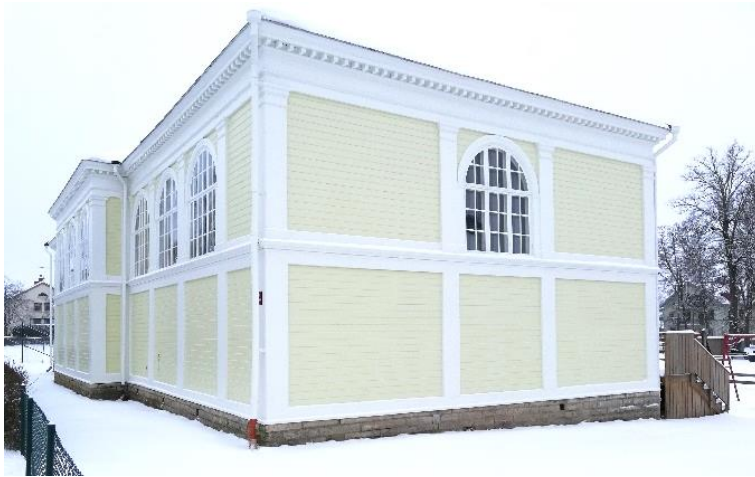
Figur 13. Annexet sett från Sturegatan.
