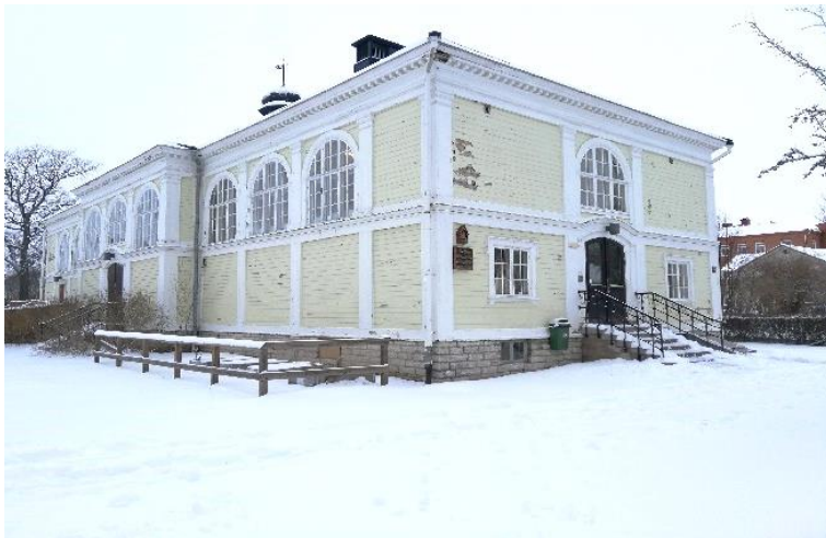
Figur 12. Annexet sett från skolgården.
