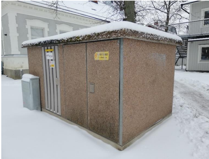
Figur 28. Transformatorstationen sedd från skolgården.
