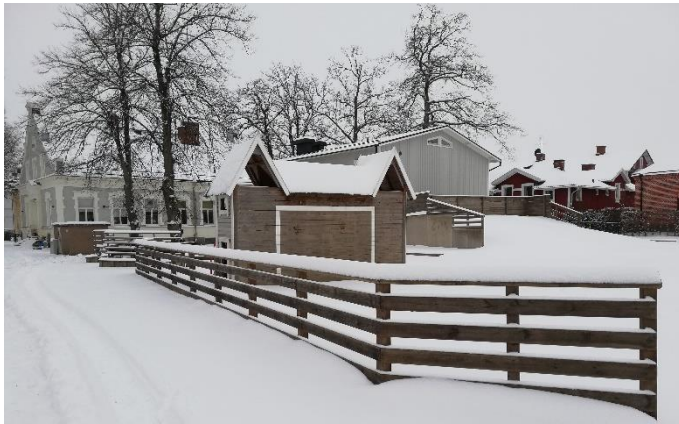
Figur 32. Lekkonstruktionen sedd från skolgårdens mitt.
