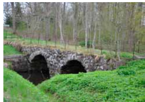
Stenvalvsbro vid Gudhem
