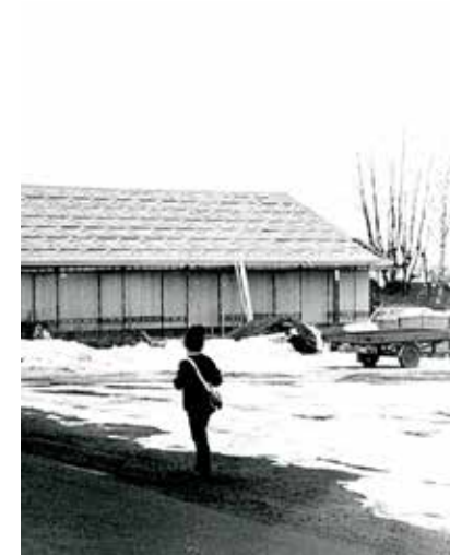
Nya affären byggs 5
