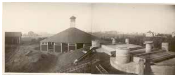
Bild 3. Skaras första reningsverk,
