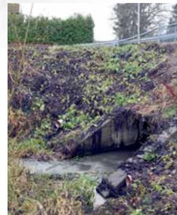
Tunnel för Drysan
