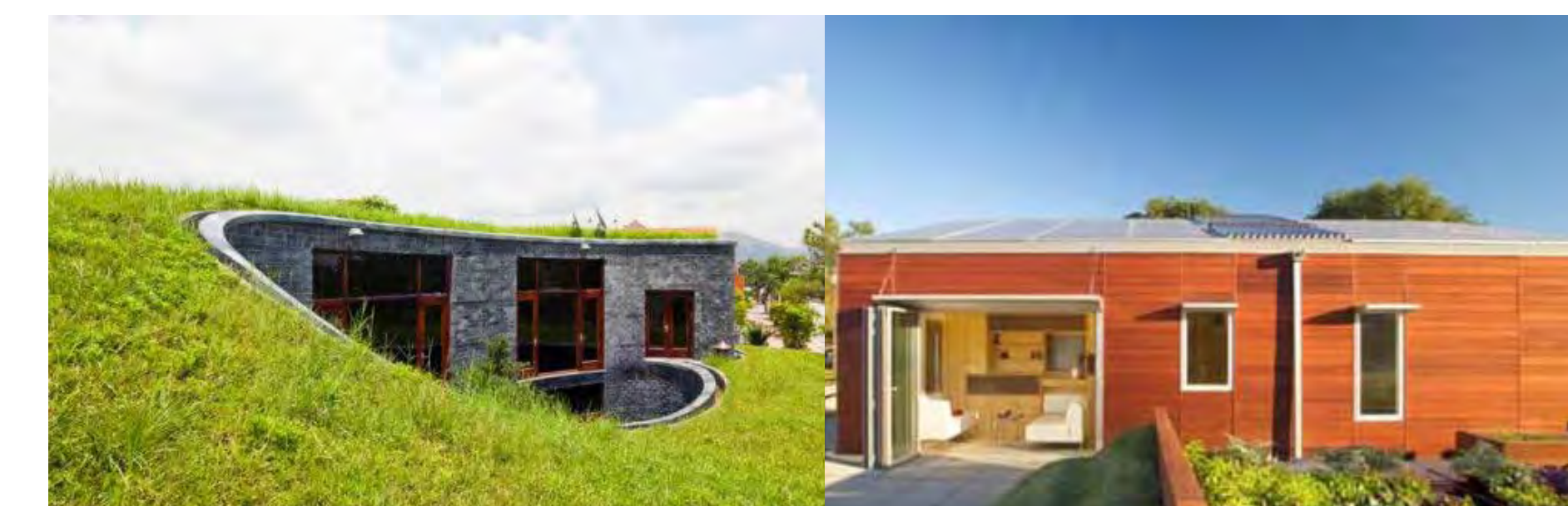
Stone House, grönt tak med många positiva egenskaper såsom isolering, absorbering av regnvatten, binder luftföroreningar och dämpar buller.
