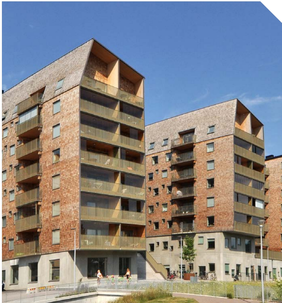
Kvarteret Geologen "Trummens Strand" Växjö Fem hus i massivträ, 144 bostadsrätter och förskola, färdigställt 2019.
