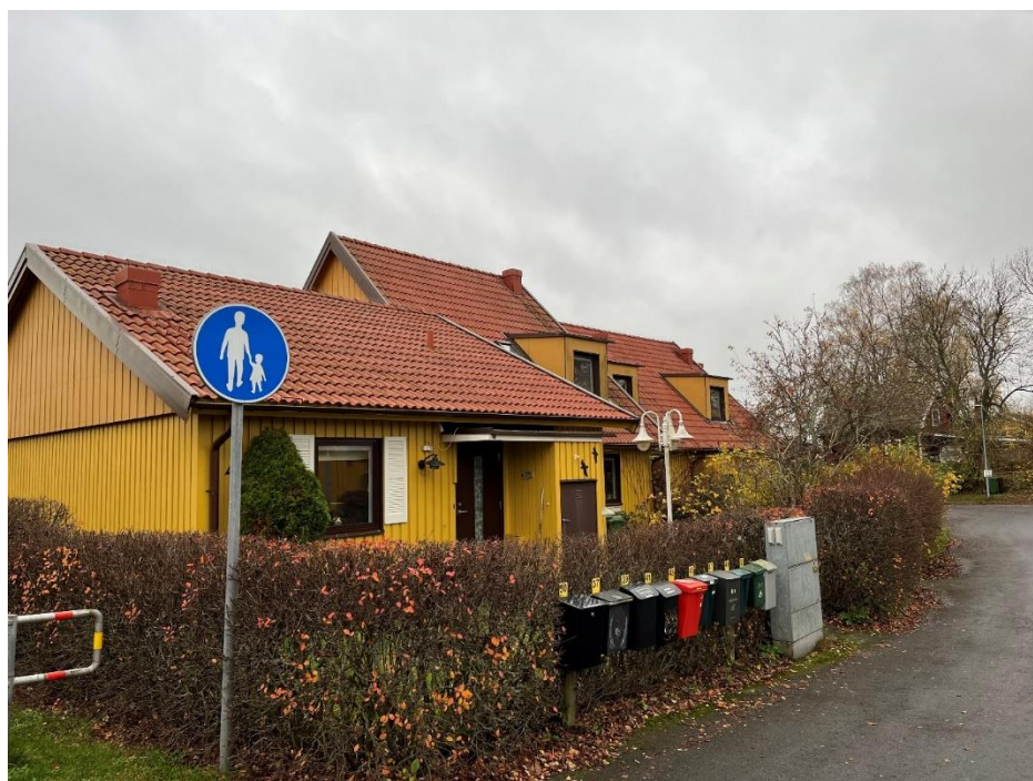
Figur 1 - Radhus i gult vid Fodgegårdsvägen. Längst fram syns hus lägre takvinkel och nockhöjd.
