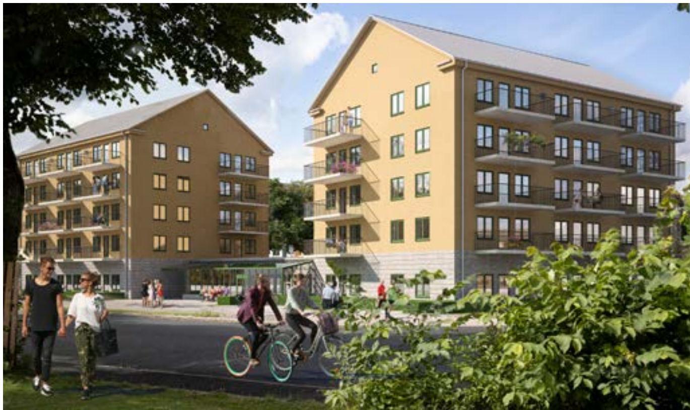
Centrumbostäder i Skara AB planerar för att uppföra bostäder för äldre på stationsområdet i det nybildade kvarteret Stinsen i centrala Skara. Byggnation planeras för ca 48 lägenheter samt gemensamhetslokal.
